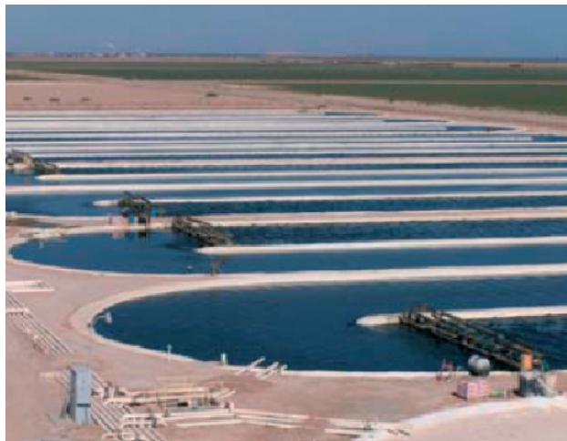
5. ábra: Spirulina nagyüzemi előállítására használt szabadtéri medencék az Earthrise Farmon (Calipatria, California) ( url 6 )
